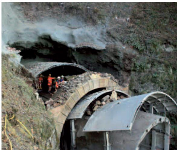
Bild 4: Tunnel-Erweiterungs-Maschine TEM 8400 [3]
