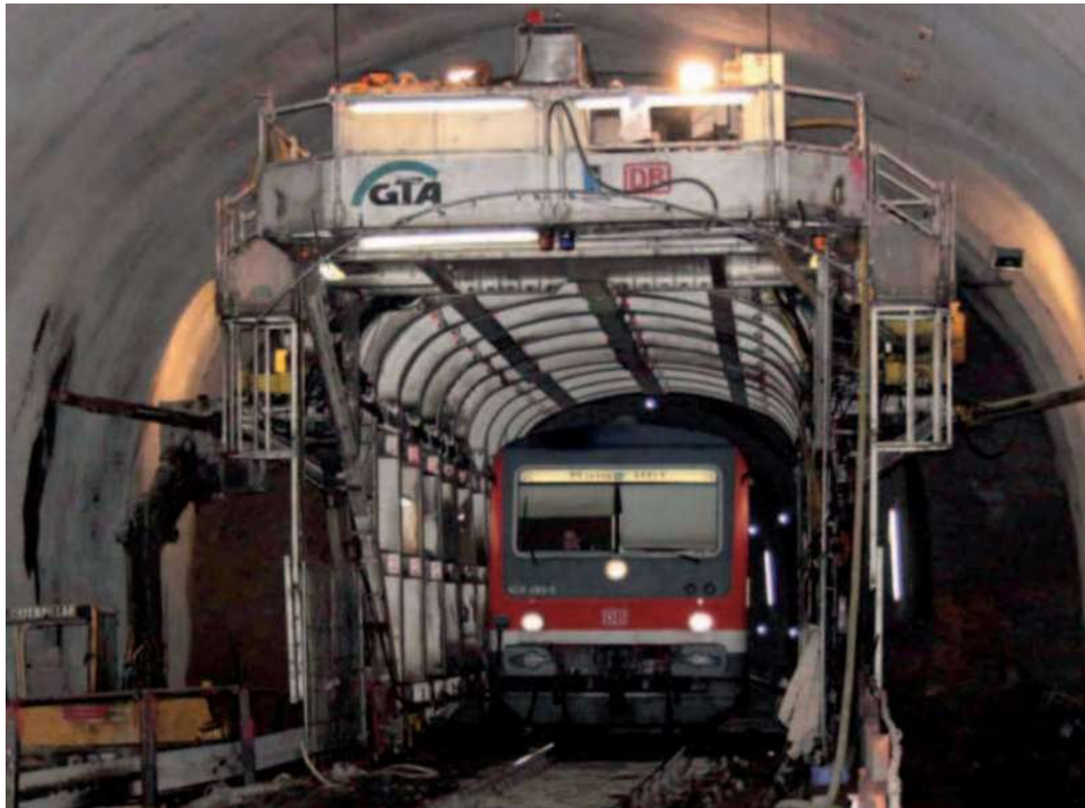
Tunnel-in-Tunnel Methode z.B. Frauenberger Tunnel, Kupferhecktunnel (Quelle: GTA)
